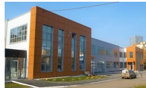
Учебно-производственные мастерские, Пермский строительный колледж
