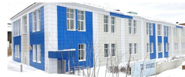
Реконструкция мастерских, Лысьвенский политехнический колледж
